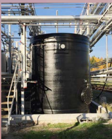
Duallaminate tank med 4 mm PE-EL liner, konduktiv. Utvändigt GAP.
