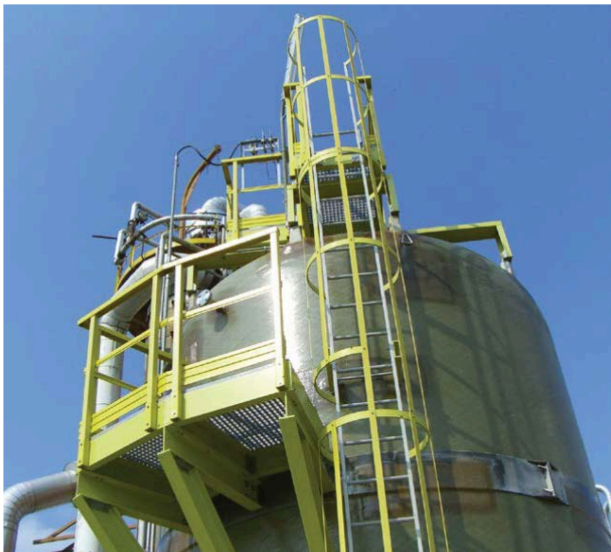
Gallerdurk, plattform och steg med fallskydd av korrosionsbeständig armerad plast.
